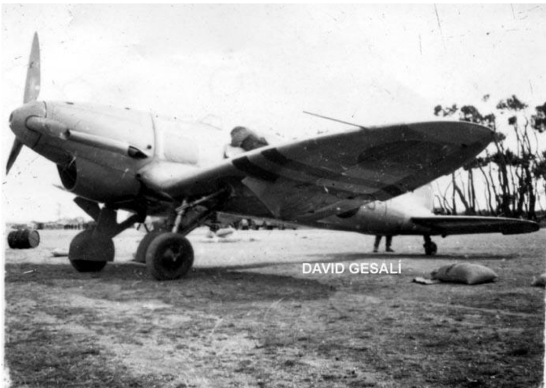
V3. Con hélice tripala Se observa claramente el círculo negro bajo el ala y las dos líneas negras paralelas
